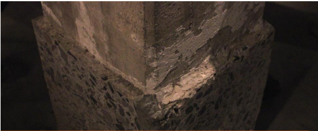
I kælderbaren kan man se, hvordan fundamentet er blevet sænket for at give mere plads.
